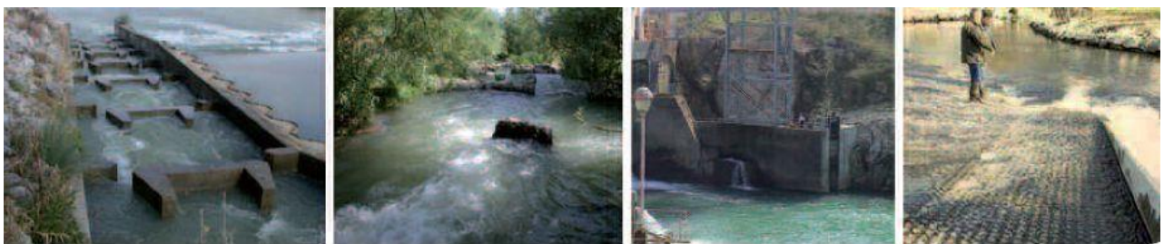
Passe à bassins successifs Passe « naturelle » Ascenseur Dispositif pour l'anguille
