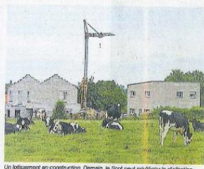
Un bâtiment en construction. Demain, le Scot peut privilégier la réalisation de logements dans les zones de densification et limiter l'étalement urbain.
